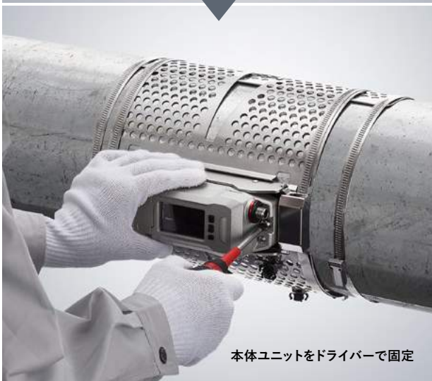
配管に金具を取り付けて…
