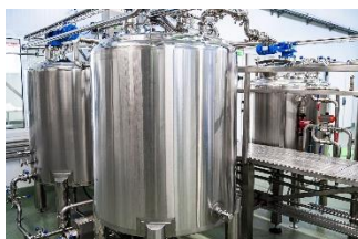
タンク残量監視
